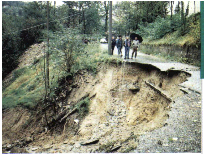
Figura 7 – Tipico movimento rotazionale, in terreni di riporto, con conseguenze gravi sulla viabilità e sulle reti di distribuzione (Comune di Boves, fonte REGIONE PIEMONTE, 1998, pag. 399)
