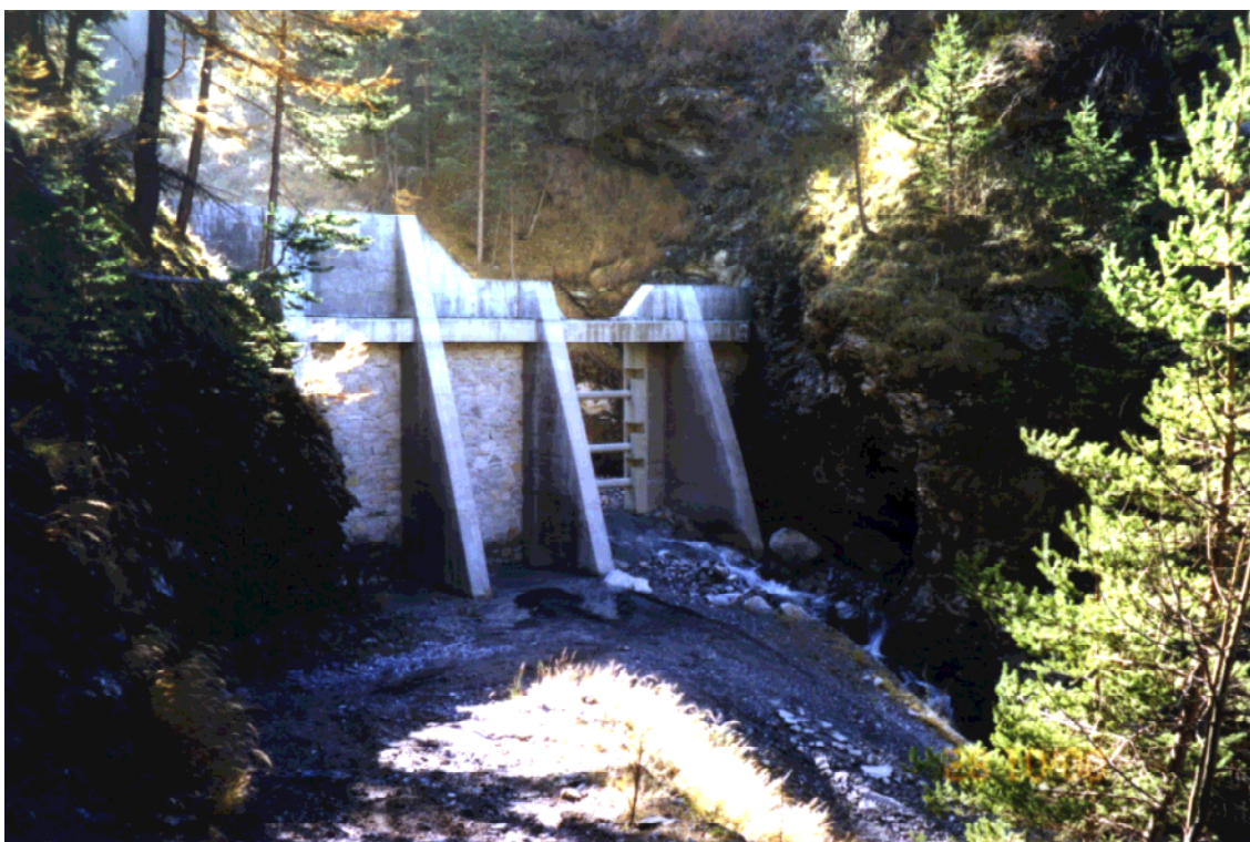
Figura 5 – Briglia a fessura a protezione di un campeggio
