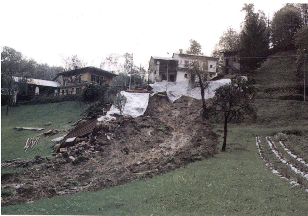
Figura 8 – Tipico movimento rotazionale con coinvolgimento di edifici (Comune di Chiusa di Pesio, fonte REGIONE PIEMONTE, 1998, pag. 400)
