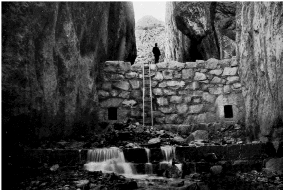
Figura 1 – Esempio di briglia di trattenuta in muratura di pietrame cementato. Si tratta quasi certamente di un'opera realizzata nell'orrido all'apice del cono di deiezione del Torrente Prebec, all'inizio del XX secolo, a protezione dell'abitato di Chianocco. L'opera è fra quelle collassate durante la piena del giugno 1957 (da ROMITI, 1957; Tav. XXII)
