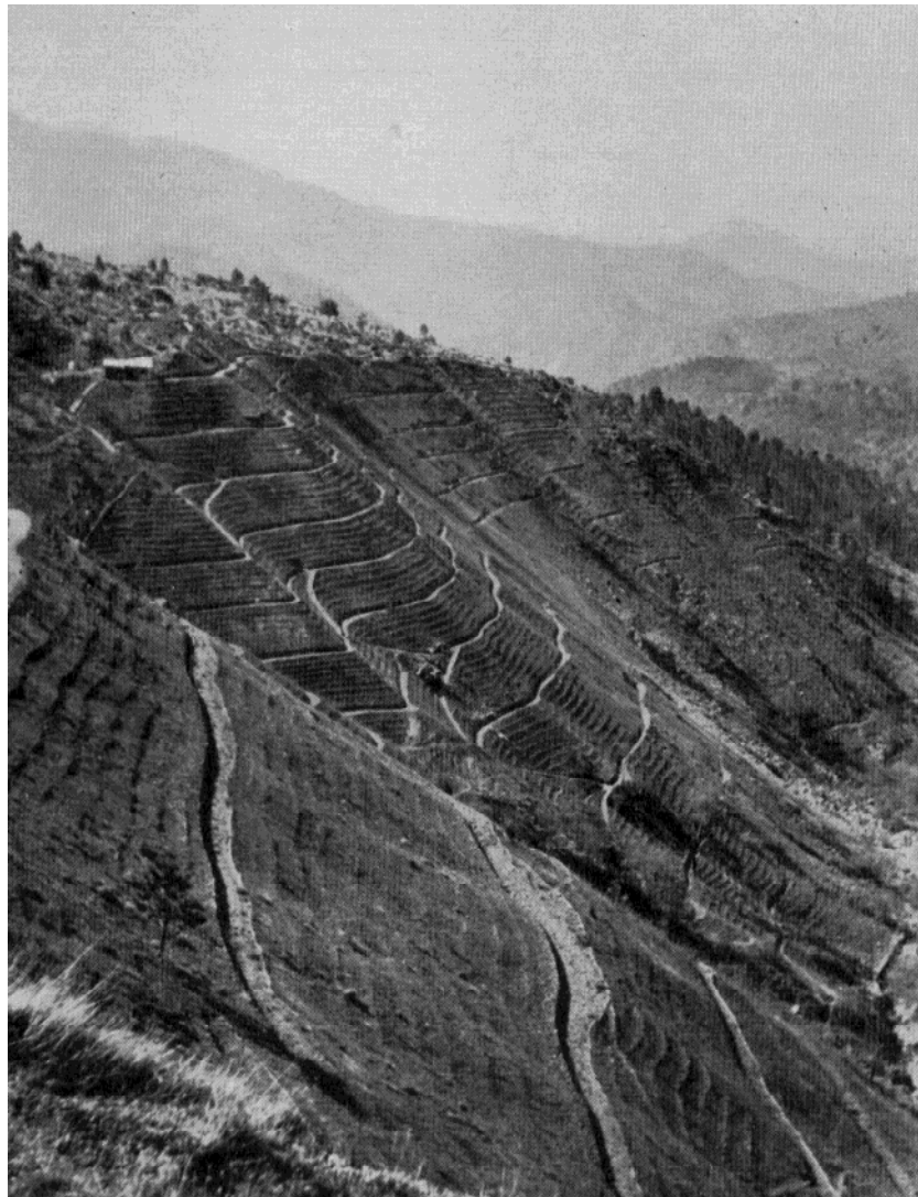
Figura 3 – Esempio di sistemazione di versante denudato con graticciate (da ROMITI, 1957; fig. 24).
